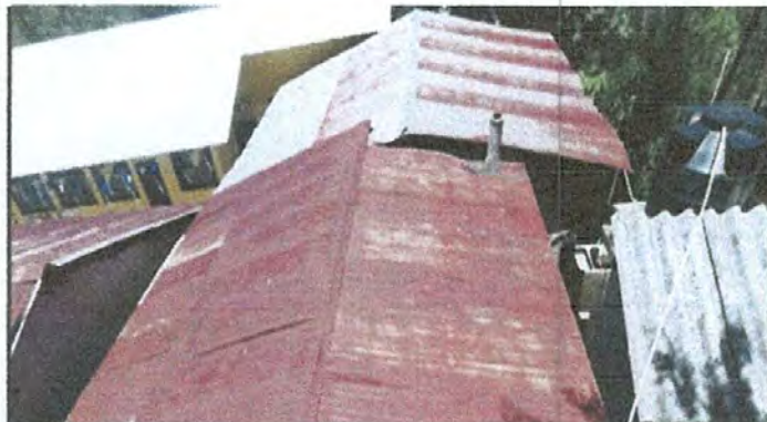
Foto 3: Sustitución de lamina aula 5
