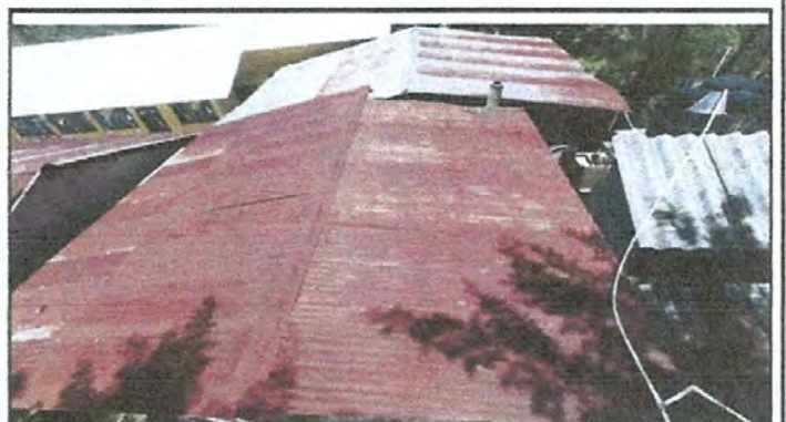
Foto 4: Sustitución de lamina de la cocina.
