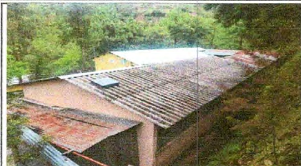
Foto1: Sustitución de lamina aula 1 y 2
