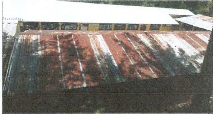
Foto 2: Sustitución de lamina aula 3 y 4
