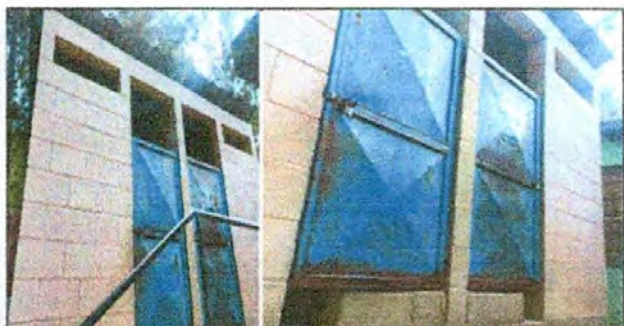
Foto 6: Sustitución de puertas.
