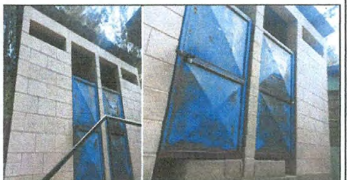
Foto 6: Sustitución de puertas.
