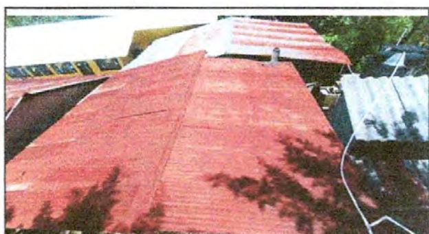
Foto 4: Sustitución de lamina de la cocina.
