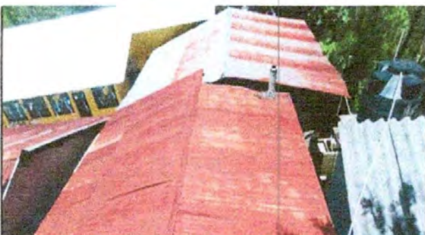
Foto 3: Sustitución de lamina aula 5
