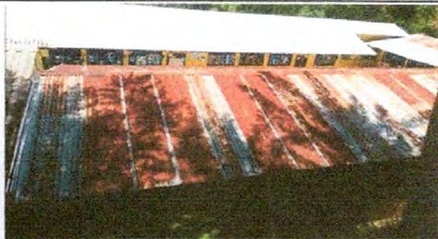
Foto 2: Sustitución de lamina aula 3 y 4
