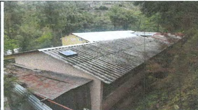
Foto1: Sustitución de lamina aula 1 y 2
